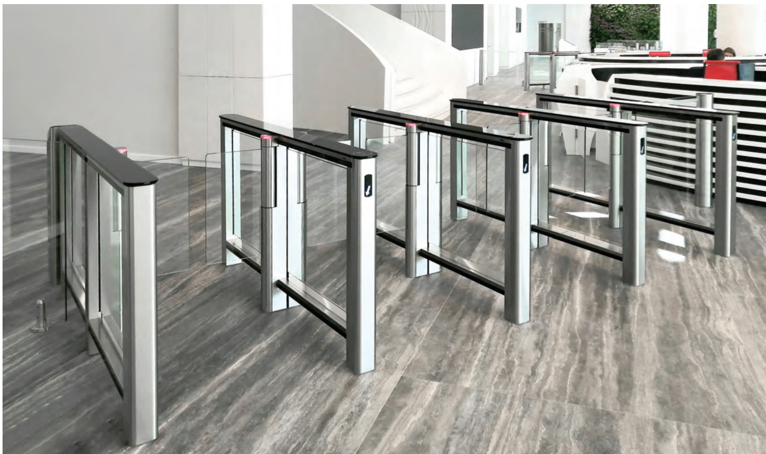
Бизнес-центр «Setl City», Санкт-Петербург
