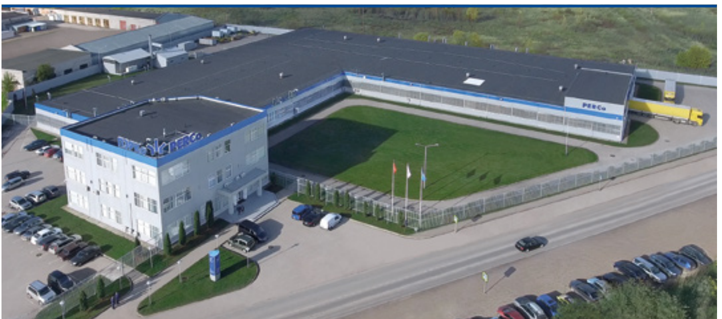
Завод в Пскове
