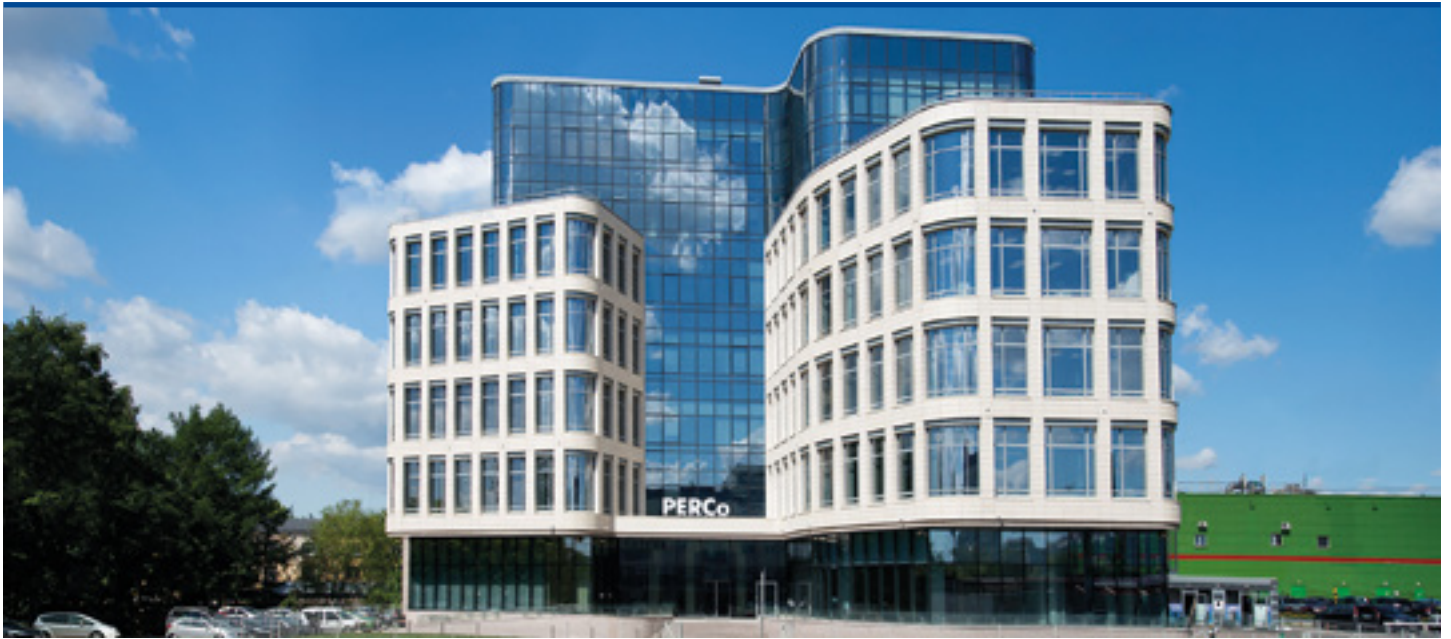
Главный офис PERCo
