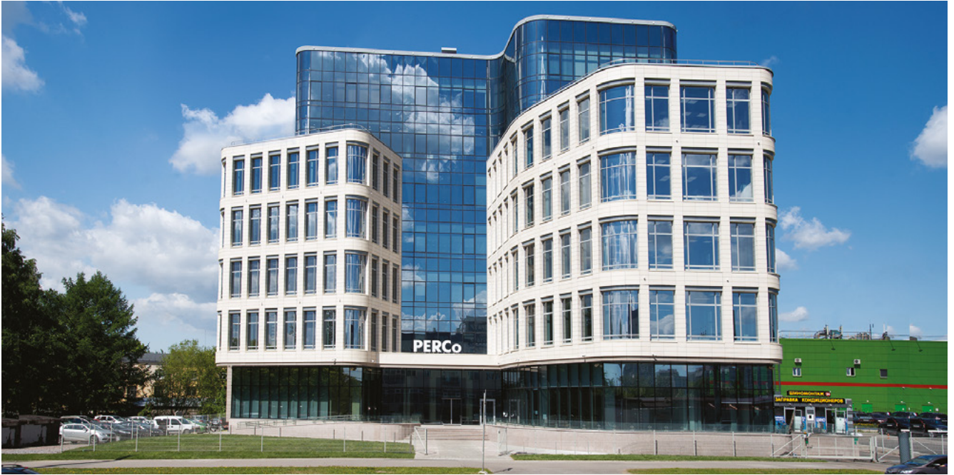
Главный офис PERCo
