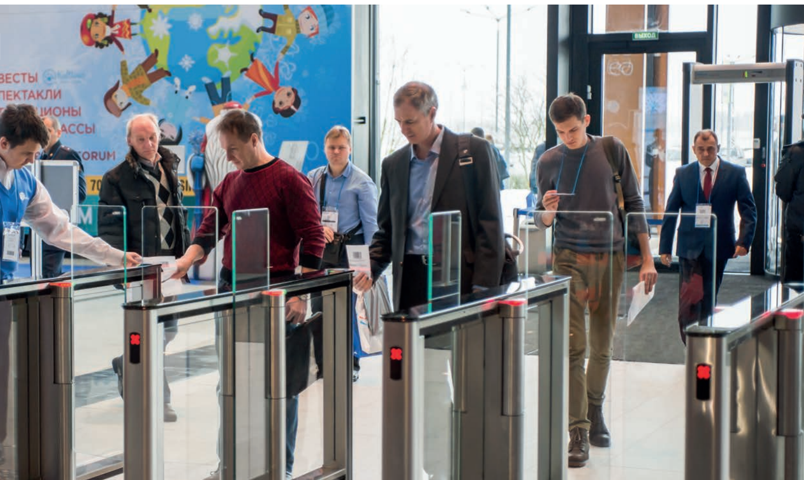
Скоростные проходы PERCo-ST01 под управлением контроллера PERCo-C01, Экспофорум, Санкт-Петербург
