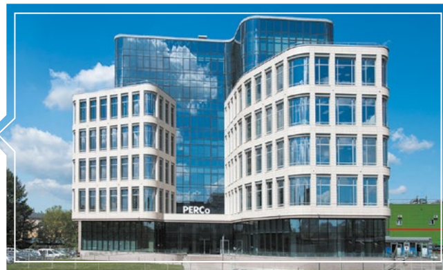
Главный офис PERCo
