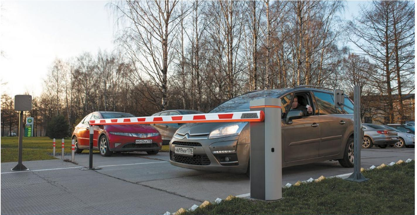
Водитель, не покидая автомобиля, предъявляет пропуск считывателю и проезжает на территорию. Считыватель работает на расстоянии до 100 см. Доступ может быть предоставлен по факту предъявления карты EMM, RFID-метки или распознавания номера автомобиля.
